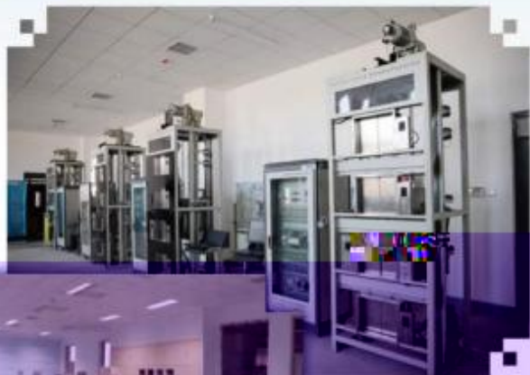
智能电梯安装调试维护训练场所
